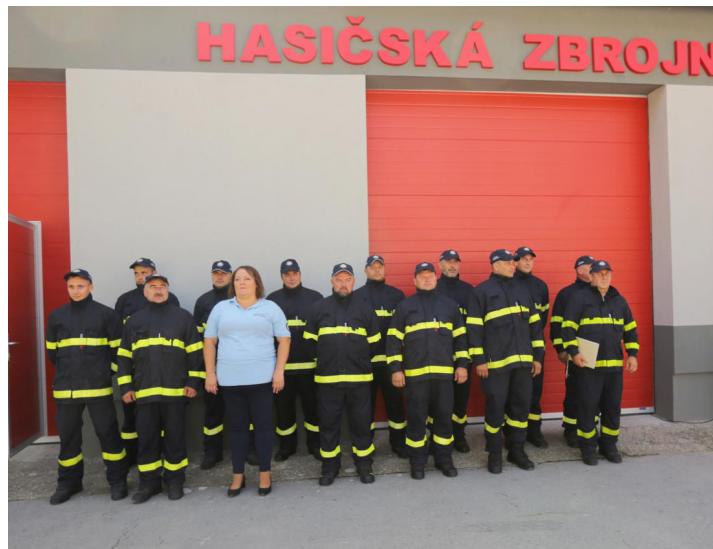
Členovia DHZ pred zrekonštruovanou hasičskou zbrojnicou.
