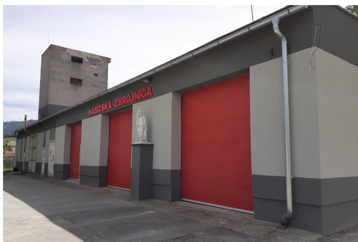
Hasičská zbrojnica po zateplení.
