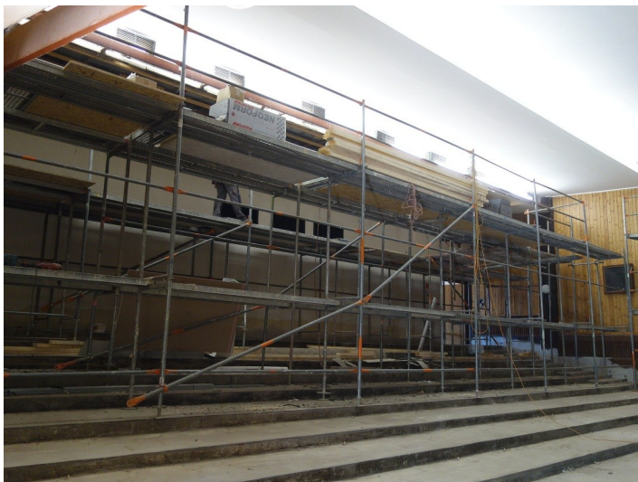
Práce na obnove sály kultúrneho domu.
