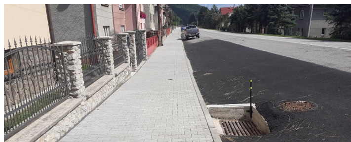
Chodník na Ulici 9.mája po rekonštrukcii s doplneným asfaltom.
