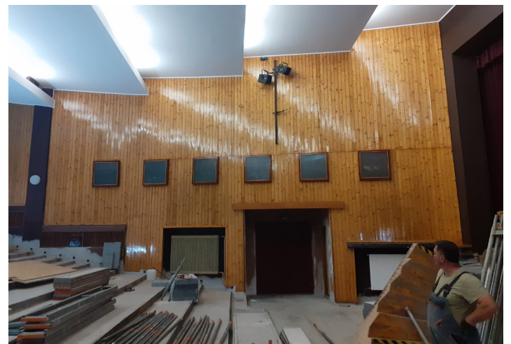
V kultúrnom dome prebiehajú práce na zlepšení tepelno-technických vlastností a estetickej hodnoty objektu.
