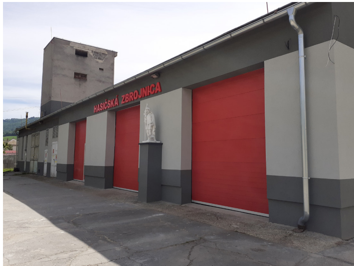
Bola ukončená tretia etapa rekonštrukcie hasičskej zbrojnice.
